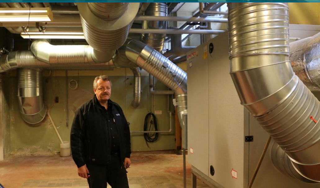
Kim tjekker ventilationssystemet på Hillerødsholmskolen
